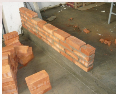
Кирпичная перегородка (160 мм)
