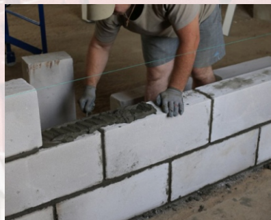
Пенобетонная перегородка (90 мм)
