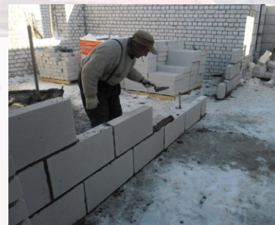
Газобетонная перегородка (85-110 мм)
