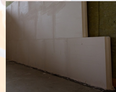
Перегородка из ПГП (80-100 мм)
